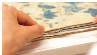
解体作業の様子(撮影:凸版印刷株式会社)
