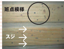
オリジナルのタイル。同じようなスジをつけるためにホールキーなどを使用する「デコレーター」を使用しました
