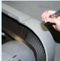
7 空調機のモーターベルトを点検
