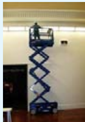
13 本館17室で蛍光灯の取替え作業
