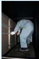
9 空調機のフィルターを交換。真っ黒になったフィルターを取り外し、新しい白いフィルターをつける
