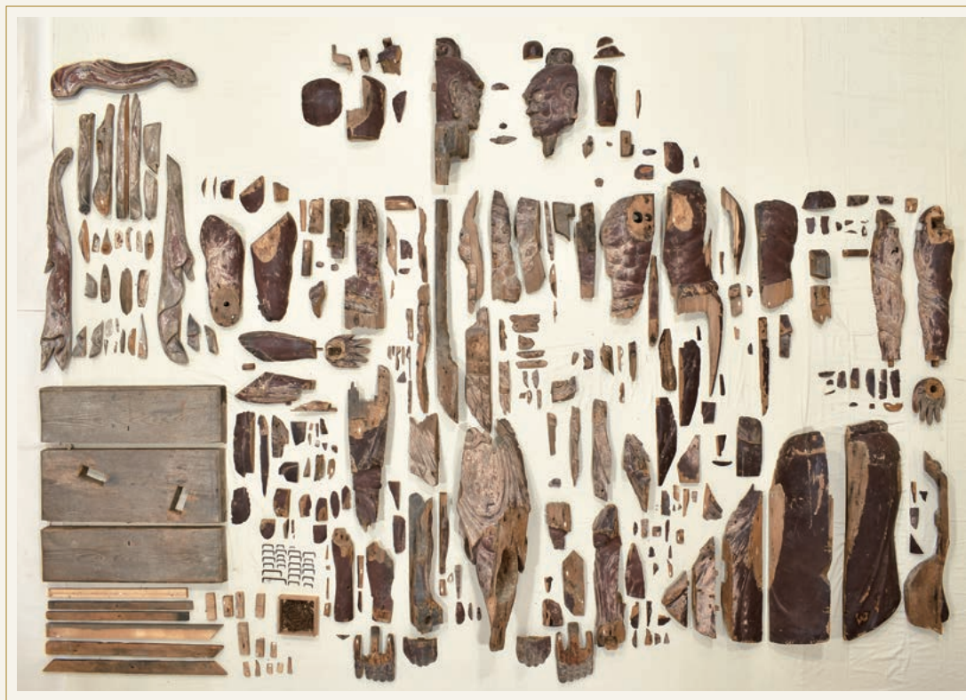
卍形 修理中（解体）
