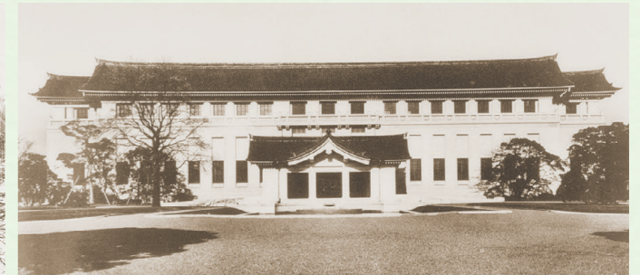
完成当時の復興本館。正面玄関手前のユリノキが現在よりもかなり小さい。
