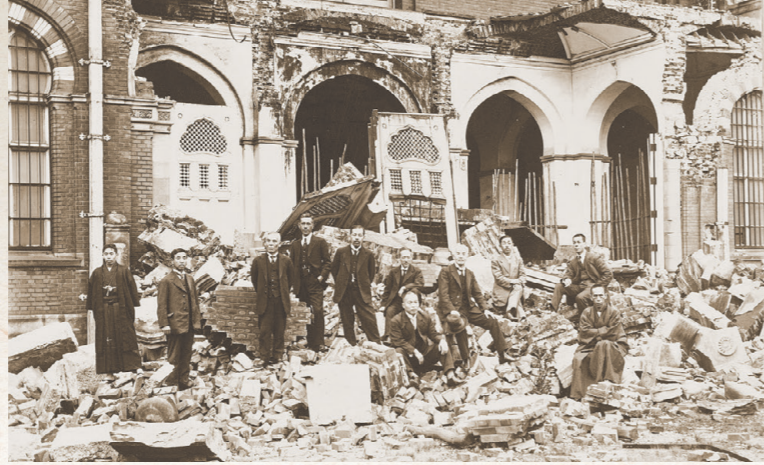
震災後、旧本館前で撮られた職員の写真。足元には崩落した煉瓦が積み重なっている。
