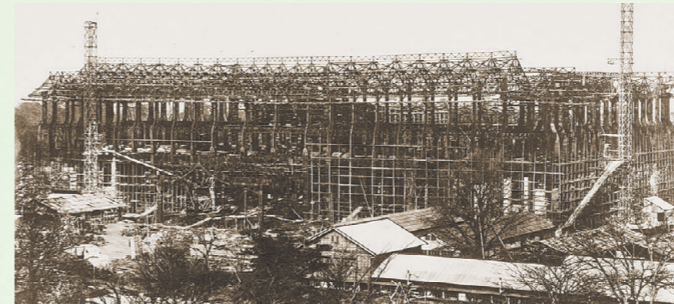
建設中の復興本館。鉄骨が組み上がっている。
