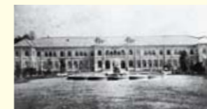
Premier bâtiment du HONKAN
